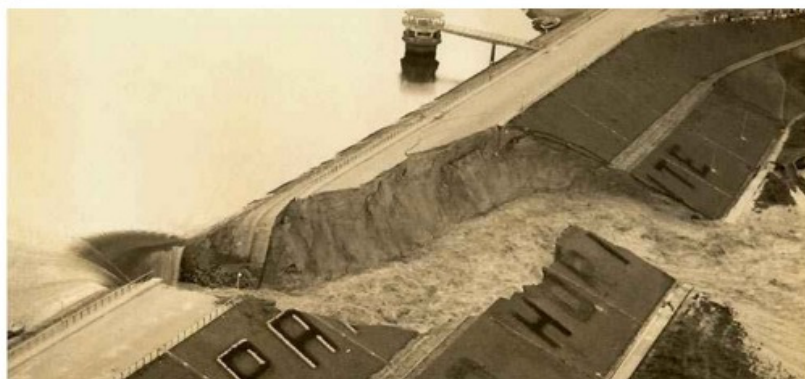
A fenda aberta na barragem levou parte das palavras gravadas no cimento (foto: Eugênio Silva/O Cruzeiro/EM)
